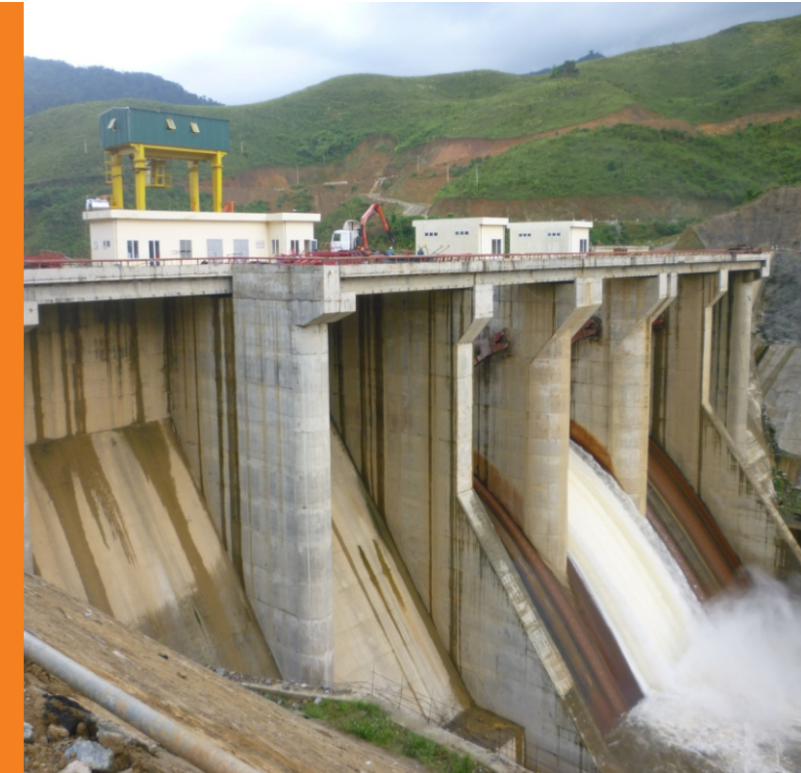
Đập tràn nhà máy thủy điện A Lưới
